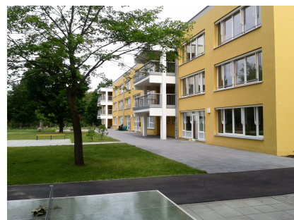
Nach der Fertigstellung
