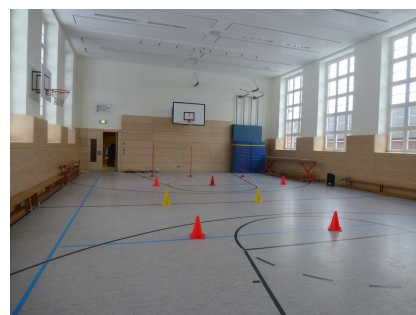
Die sanierte Sporthalle mit Prallwand, Akustikdecke und neuen Fenstern
