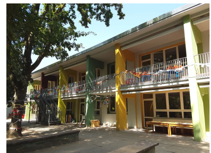
Die sanierte Kita der Vielfarb gGmbH
