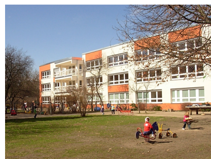
Das Gebäude wurde bis Ende 2012 saniert
