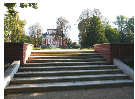
Sanierte historische Treppe mit Blick zur Schlosskirche
