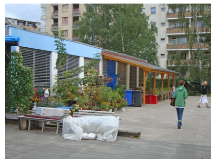
Das Gebäude vor der Sanierung
