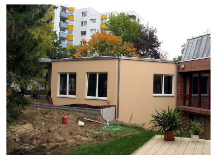
Der Kita-Anbau kurz vor der Fertigstellung
