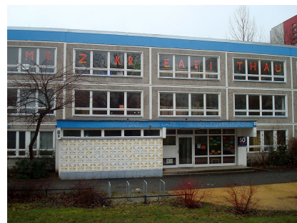
Das Gebäude vor der Sanierung
