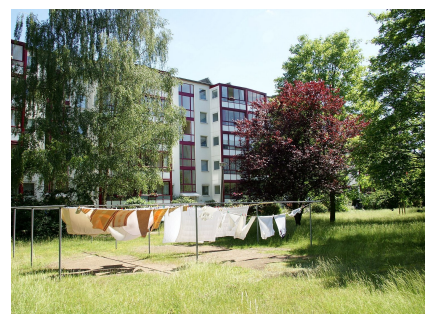
Großzügige Innenhöfe nördlich der Michelangelostraße
