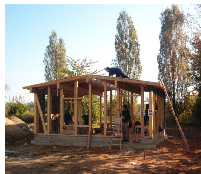
Die Ökoloabe im Bau
