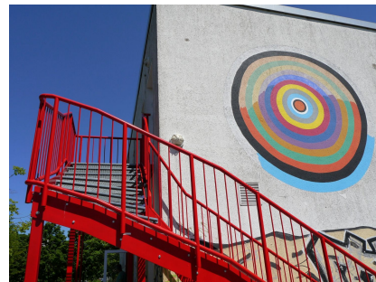
Der 2. Fluchtweg wurde 2008 angebracht
