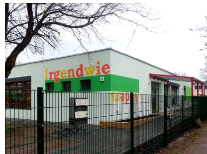
Die Kita an der Flämingstraße nach der Sanierung
