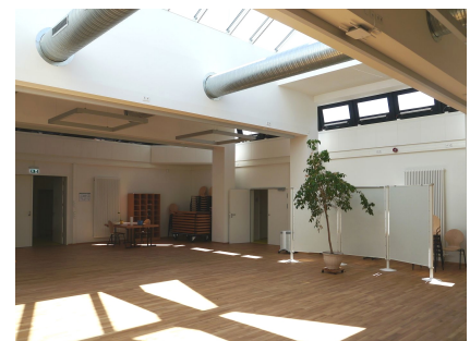
Der Veranstaltungssaal mit zusätzlichen Lichtfugen
