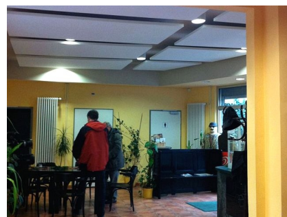
Das Foyercafé ist mit Akustiksegeln ausgestattet
