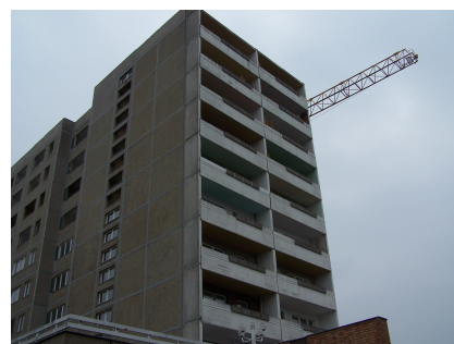
Teilrückbau des Elf-Geschossers im März 2006
