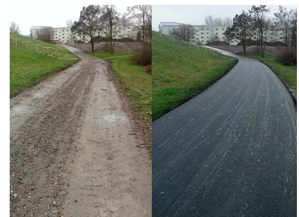
Die zukünftige Rollsportstrecke wurde asphaltiert
