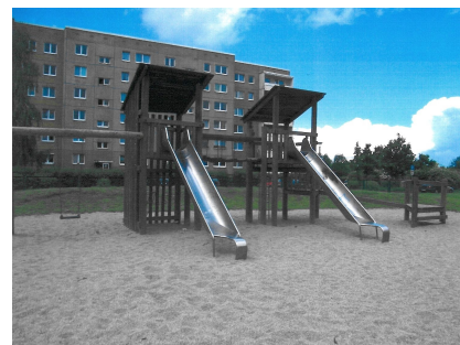
Die alte Anlage bis Herbst 2014
