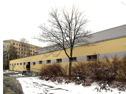
Die Fassade nach der Sanierung im März 2013
