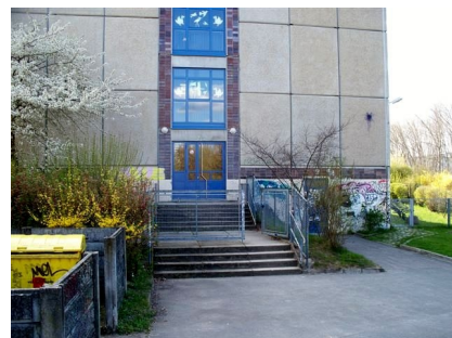
Hier wurde der neue Gebäudeteil angefügt
