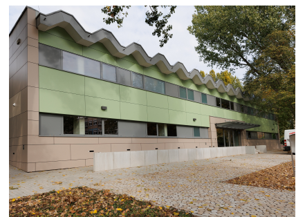
Die sanierte Typen-Sporthalle
