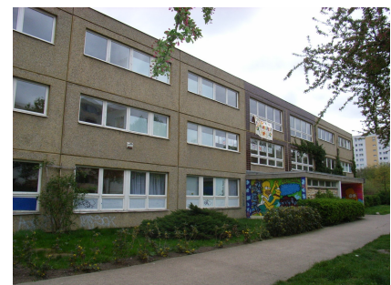
Das Gebäude vor der energetischen Sanierung
