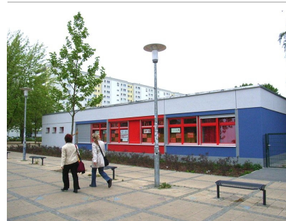
Das Mädchensportzentrum 2008 nach der Fassadensanierung
