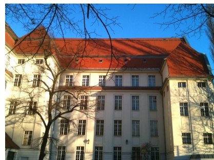
Der Nordflügel wurde neu verputzt
