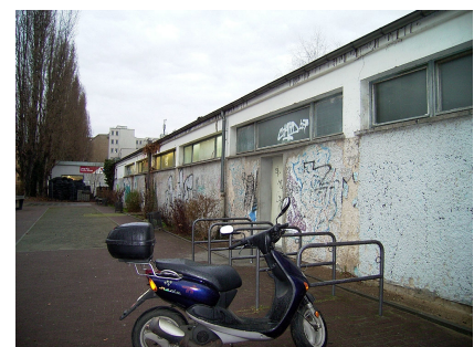
Das Funktionsgebäude vor dem Umbau
