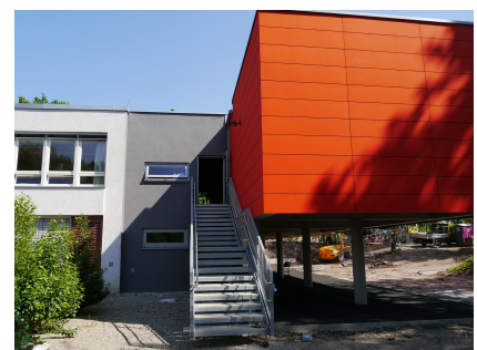
Die Gebäudeverbindung zur benachbarten Kita
