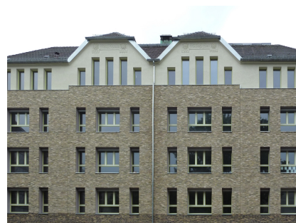
Die gleiche Fassade zum Projektabschluss
