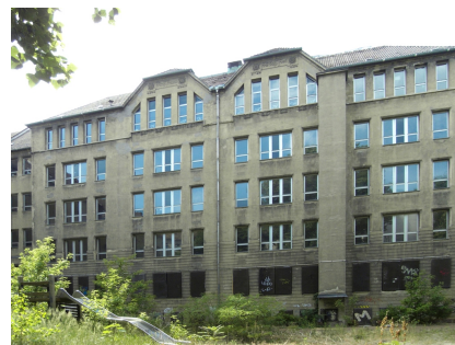
Die Hoffassade vor der Sanierung
