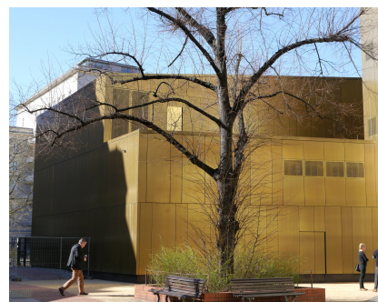
Der Konzertsaal bildet einen weiteren architektonischen Höhepunkt am Frankfurter Tor
