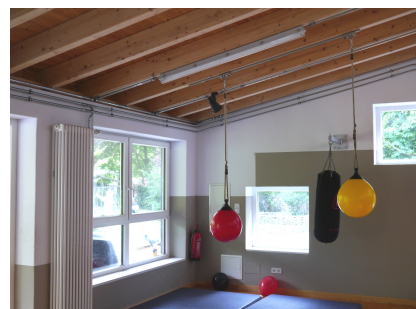
Blick in den Sportraum im Erweiterungsbau
