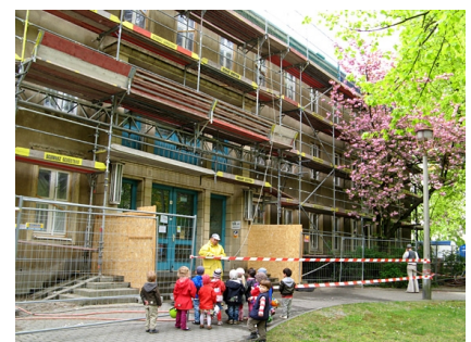
Der Kindergarten wurde bei laufendem Betrieb saniert
