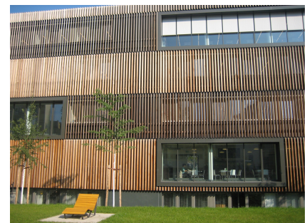
Der Typenbau erhielt eine Holzlamellenfassade
