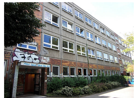
Die Schule vor der Sanierung
