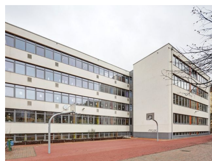
Die hofseitige Fassade nach der Sanierung
