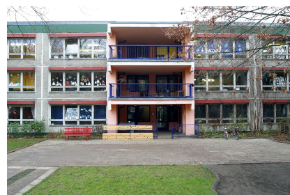
Die Fassade an der Gartenseite vor Projektbeginn
