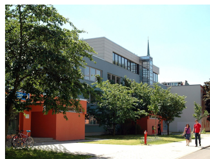
Das Gebäude wurde saniert und aufgestockt
