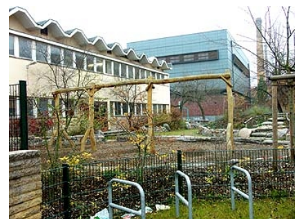
Die kleine Sporthalle vor der Sanierung
