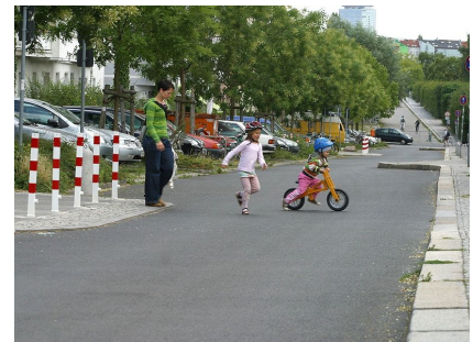
Gehwegvorstreckungen erleichtern allen das Queren der Fahrbahn
