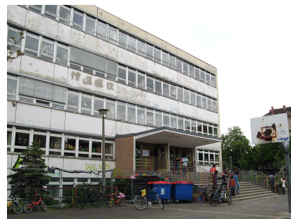
Die Schule vor Baubeginn
