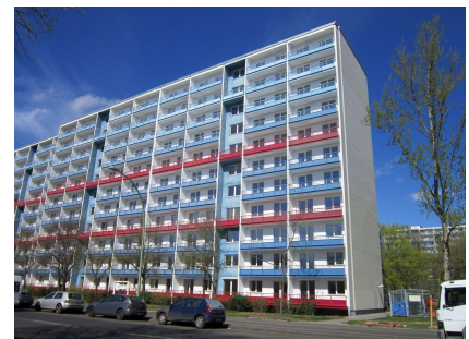
Teilsanierter Elfgeschoßer des Typs P2
