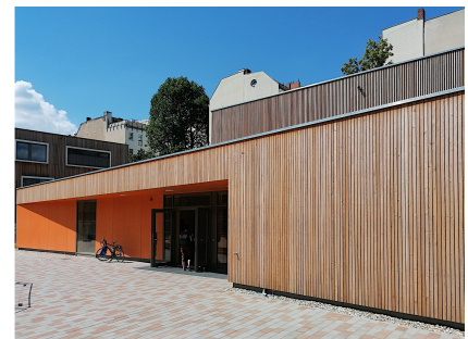
Die neue Sporthalle der Johannes-Schule
