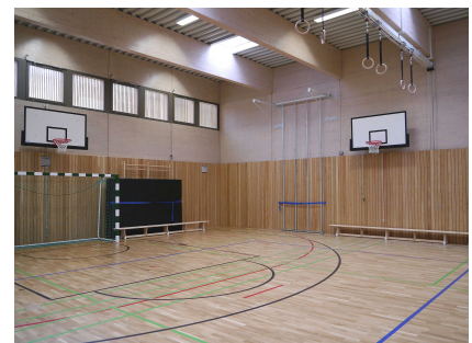
Konstruktion, Wandverkleidung und Sportparkett sind aus Holz
