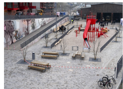
Blick von der Monumentenbrücke zum Lokdepot
